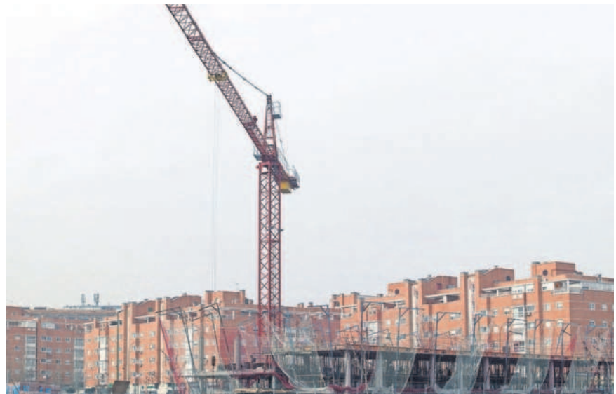
Promoción de viviendas en construcción en Madrid. PABLO MONGE
